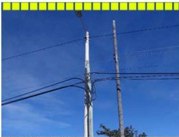
POSTES MIXTOS: Se refiere a la red en los cuales se encuentran interconectados los postes de energía eléctrica de varios materiales como madera y hormigón. Abarcando la zona C.
